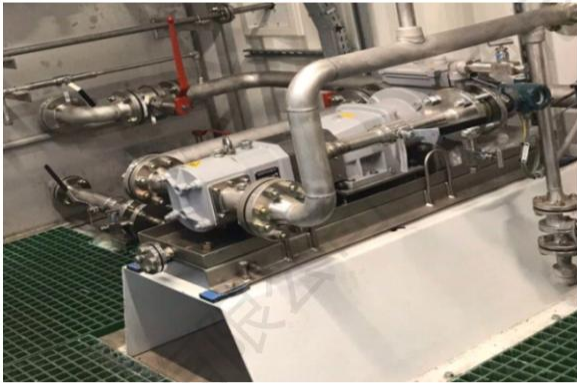
金属转子泵在DMSO项目现场
