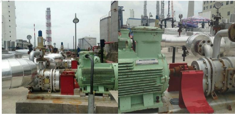
转子泵在沥青输送现场
